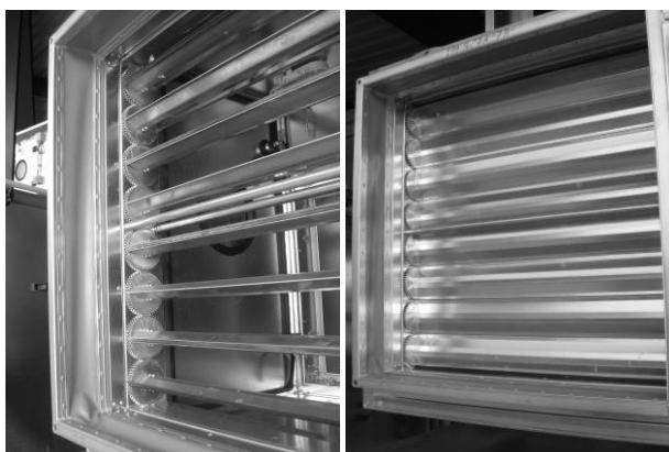
Der Jalousiekappsteller kann sowohl innen als auch außen am Gehäuse montiert werden. Bei Geräten mit Außenaufstellung ist er innerhalb des Gerätes zu montieren oder gegen Nässe zu schützen.
