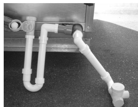
Die Siphonhöhe ist abhängig von der Druckhöhe korrekt zu dimensionieren.
