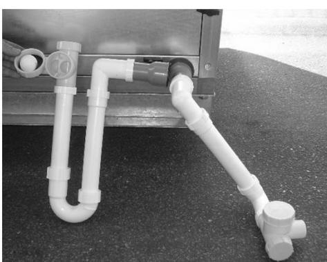
Die Siphonhöhe ist abhängig von der Druckhöhe korrekt zu dimensionieren.
