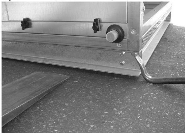
Die maximale Traglast des Staplers darf beim Transport der Module nicht überschritten werden. Wenn das Gerät mit einem Blechgrundrahmen ausgestattet ist, muss die Gabelträgerbreite des Staplers mindestens 1310 mm betragen, um die vorgesehenen Transportöffnungen nutzen zu können.
