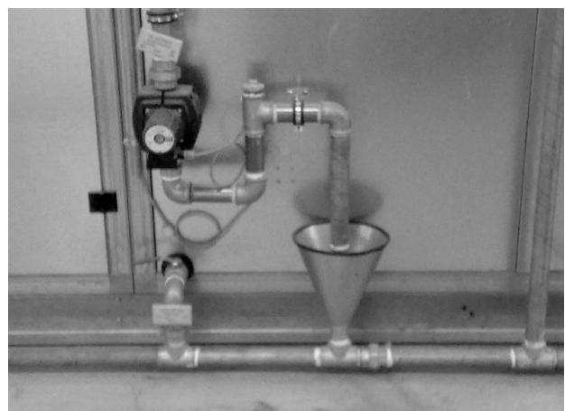
Horizontale Ablaufleitungen müssen ausreichenden Durchmesser, Gefälle sowie eine Belüftung und Entlüftung zum störungsfreien Wasserablauf haben.
