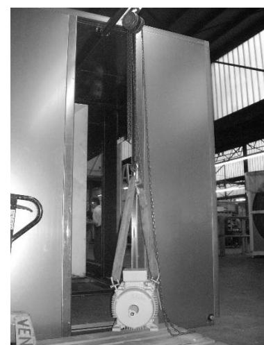
Laufrolle und Kettenzug dürfen nur bei Wartungsarbeiten montiert und müssen nach deren Abschluss entfernt werden. Sie dürfen im Lüftungsbetrieb nicht im Gerät verbleiben. Die Prüfung der Auszugsschiene, Laufrolle und Kettenzug muss regelmäßig nach DGUV V54 (Winden, Hub- und Zuggeräte) durchgeführt werden.
