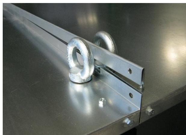
**!** Das Gerätedach ist nur bedingt begehbar. Sollte das Betreten unvermeidbar sein, ist darauf zu achten, dass das Gerätedach dabei nicht beschädigt wird. Es ist zu empfehlen die Flächen, die betreten werden müssen mit großflächigen Druckverteilungsplatten auszulegen, um die Last gleichmäßig zu verteilen.
