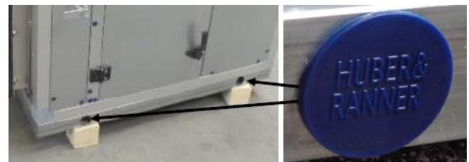
Zwischengrundrahmen die sich im Luftstrom befinden sind auch auf der Innenseite mit den blauen Abdeckstopfen zu verschließen.
